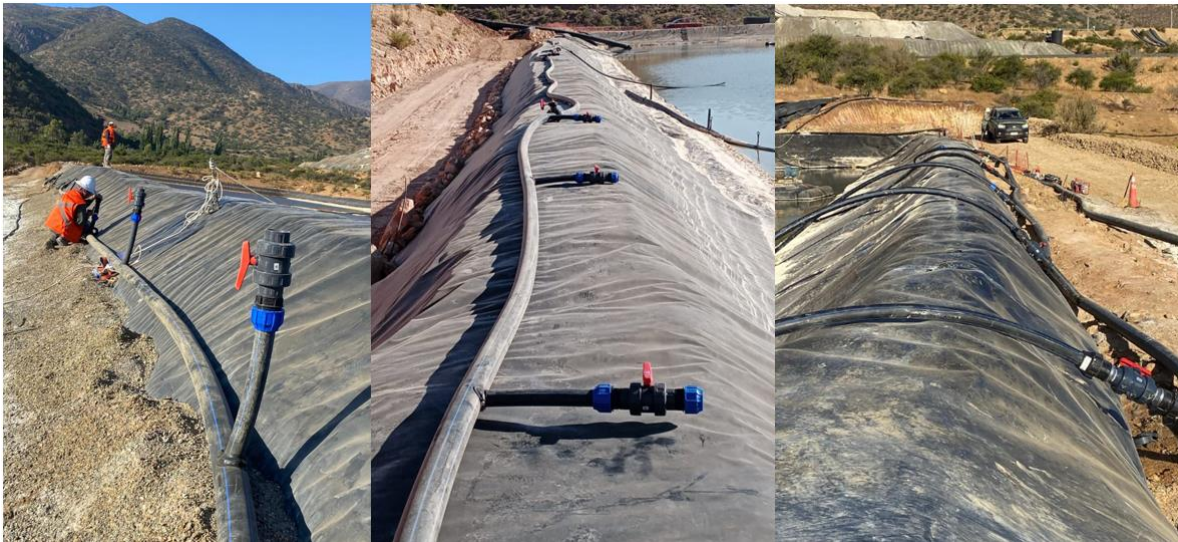
Anillo hidráulico en piscina de emergencia auxiliar
